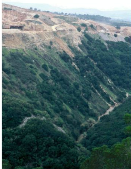
Fig. 84 - Escombrelas de pedra soterrando a vertente natural do vale do Rio da Ota e atingindo a linha de água (Atouguia das Cabras).
